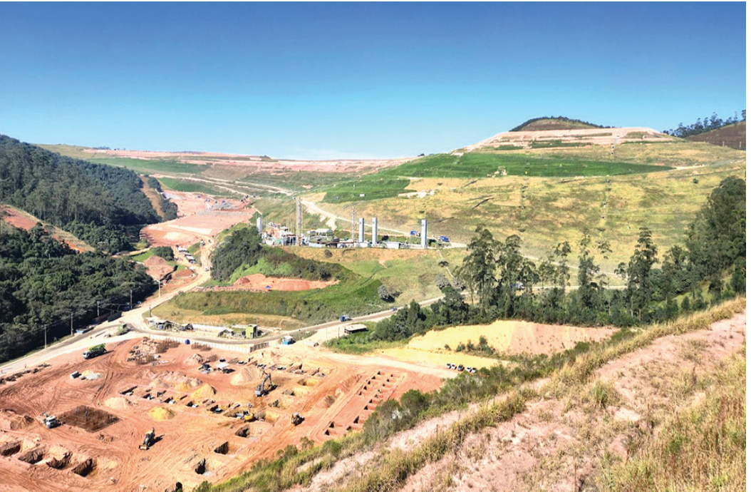
Vista aérea do terreno onde será construída a UTMB (lado inferior esquerdo), com parte do Aterro CTL ao fundo
